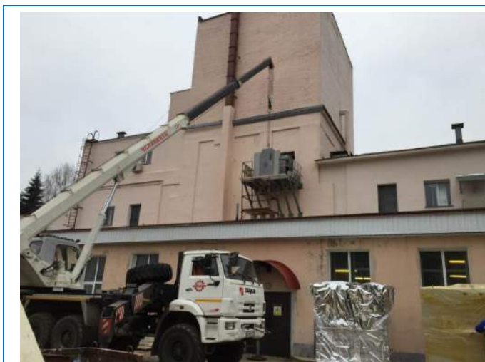
Рис. 27. Подъем модуляторов в зал ускорителя через специально сделанный транспортный проем.
