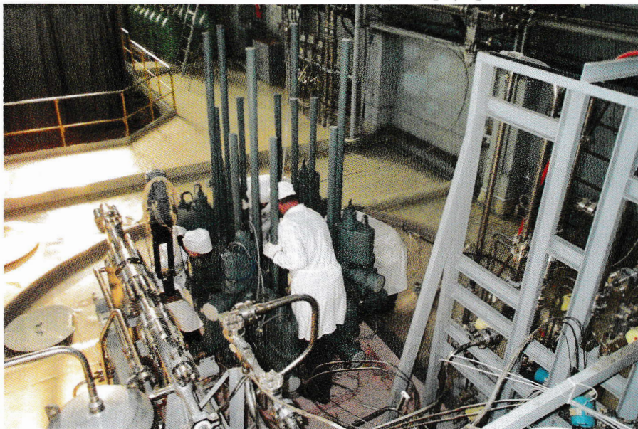
Работы по обслуживанию систем реактора ИГР
