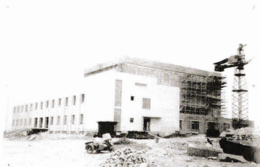
Стены корпуса атомного реактора подняты
